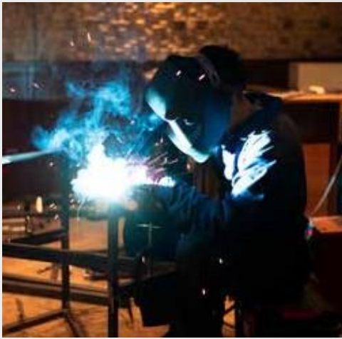
Trabajos en caliente
