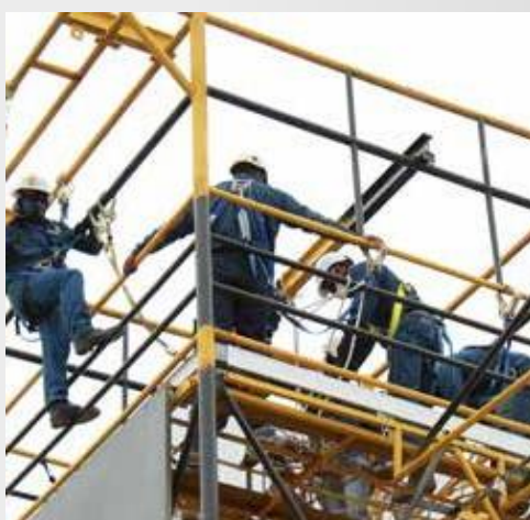
Armado de andamios
