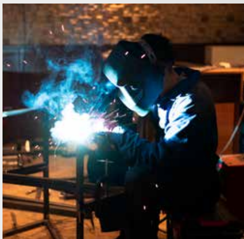
Trabajos en caliente
