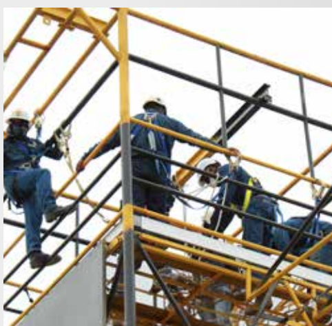
Armado de andamios
