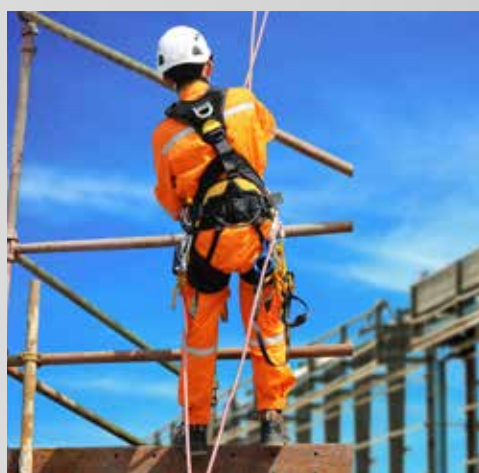
Trabajo en alturas
